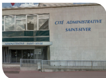
Site de Rouen : Cité administrative 2, rue Saint Sever BP 36 006 76 032 ROUEN Cedex
