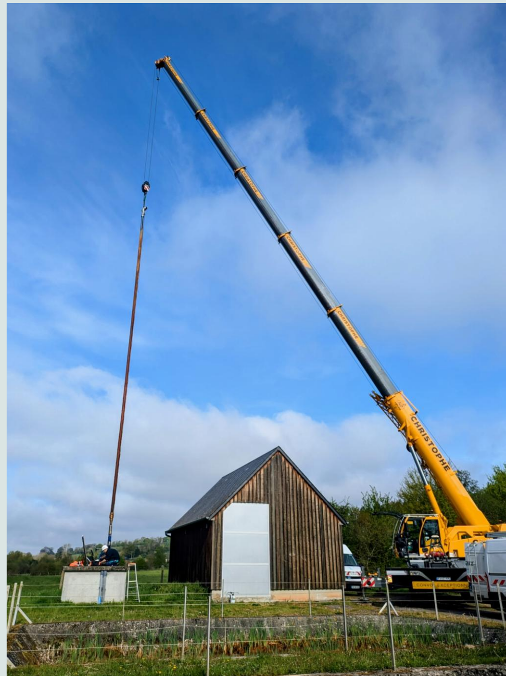
Levage des pompes du forage de Glos en 2026 pour entretien
