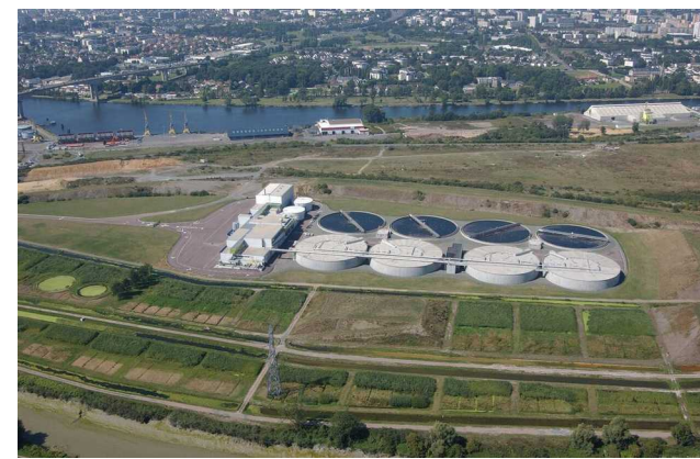
La station d'épuration du Nouveau monde sur la presqu'île. CAEN-LA-MER
