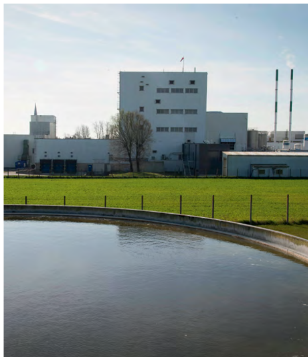
Station d'épuration pour traiter les eaux de l'usine Blédina à Steenvoorde (59)
